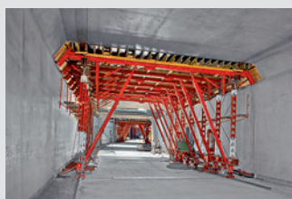
Coffrages de tunnels
