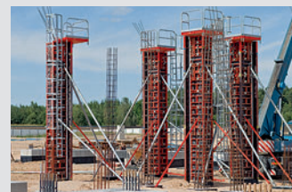
Coffrages de poteaux
